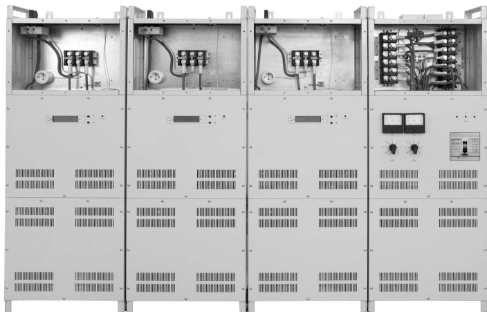
Рис.5. Расположение клеммников.
